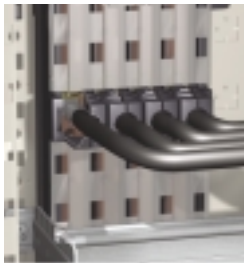
Terminais para conexão barramento/Multiclip 200 A
